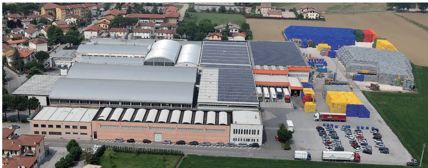
lo stabilimento Apofruit Italia di San Pietro in Vincoli, come tutti gli stabilimenti del Gruppo con il tetto bonificato con i pannelli fotovoltaici
